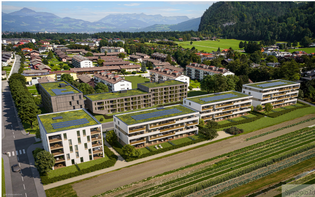
Wohnanlage in Kufstein 40 Eigentumswohnungen samt Tiefgarage
