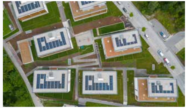
Telfs Südtiroler Siedlung, 135 kWp
