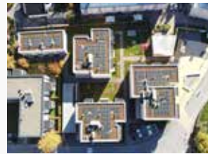
Landeck, Lötzweg, 75kWp
